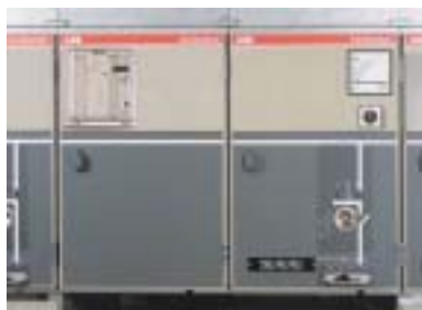
Отсек аппаратуры низкого напряжения
