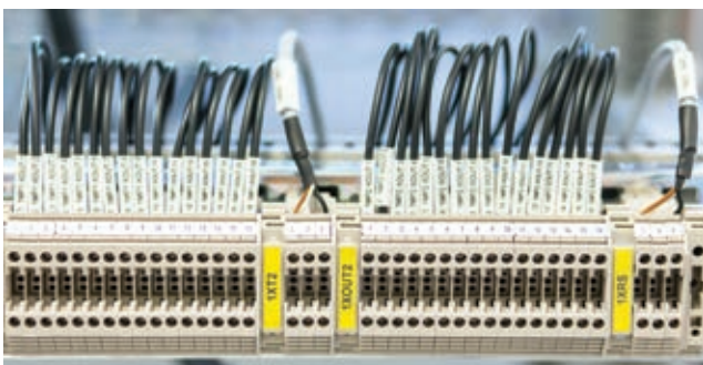
РИСУНОК – ПАНЕЛЬ ПОДКЛЮЧЕНИЯ БЕСПОТЕНЦИАЛЬНЫХ КОНТАКТОВ
