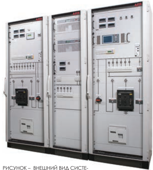
РИСУНОК – ВНЕШНИЙ ВИД СИСТЕМЫ ПИТАНИЯ СОБСТВЕННЫХ НУЖД
