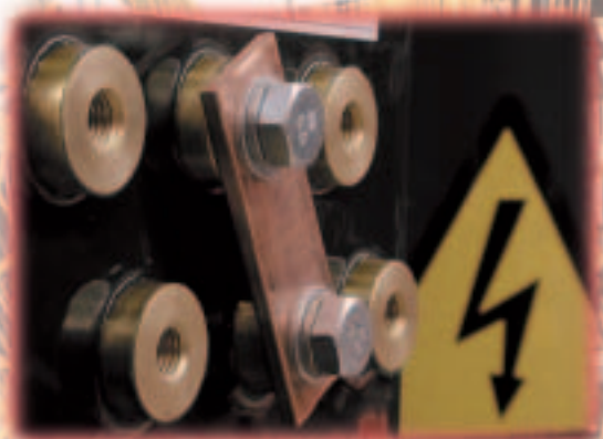
ПБВ - для регулирования напряжения посредством медных шунтов
