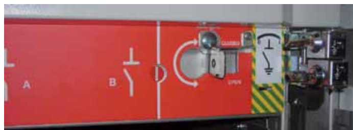
Рисунок 65. Отсеки исполнения с двумя системами сборных шин
