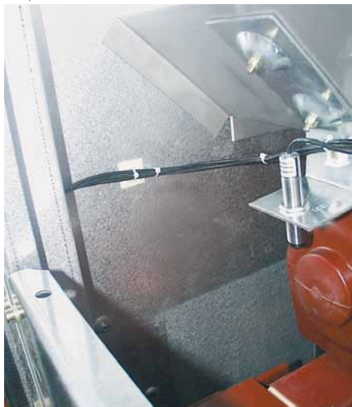
Рисунок 70. Пример термографической проверки UniGear ZS1 одноуровневого исполнения
