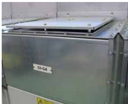
Рисунок 58. Пример распределительного устройства с компактным газовым каналом с выпуском газа через верхние дымоходные трубы (общая высота распределительного устройства составляет 2530 мм для 12–17,5 кВ до 40 кА)
