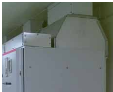
Рисунок 59. Пример распределительного устройства с стандартным газовым каналом с выпуском газа и продуктов горения через выпускное отверстие за пределы помещения (общая высота распределительного устройства составляет 2675 мм для 12–17,5 кВ до 40 кА)
