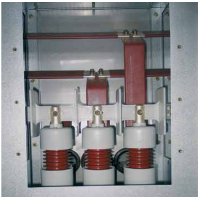
Рисунок 63. Включенное положение разъединителя сборных шин
