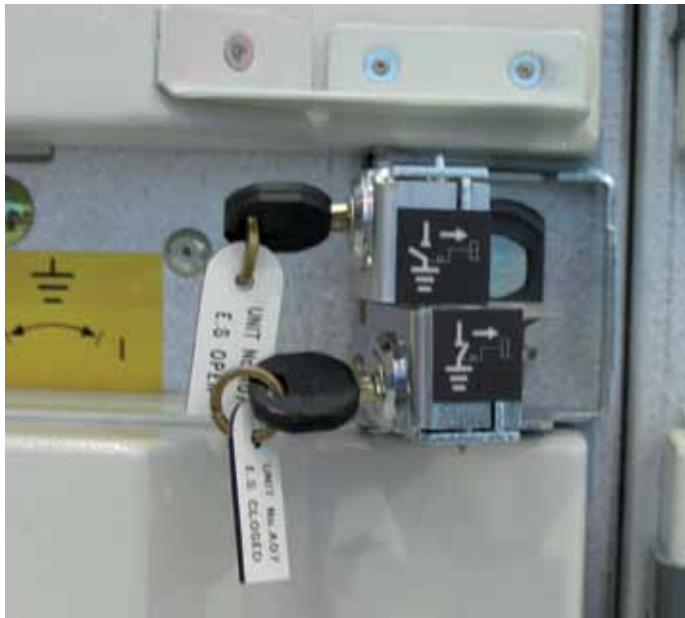
Рисунок 6. Двойной замок с ключом на заземлителе
