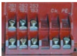
Вторичная коробка зажимов (3 обмотки и индикатор напряжения)
